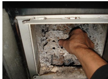
Arina nostetaan kiukaan sivuseinälle puhdistuksen ajaksi. Sitten kolataan pinnat tuhkasta puhtaaksi kohennusraudalla.
